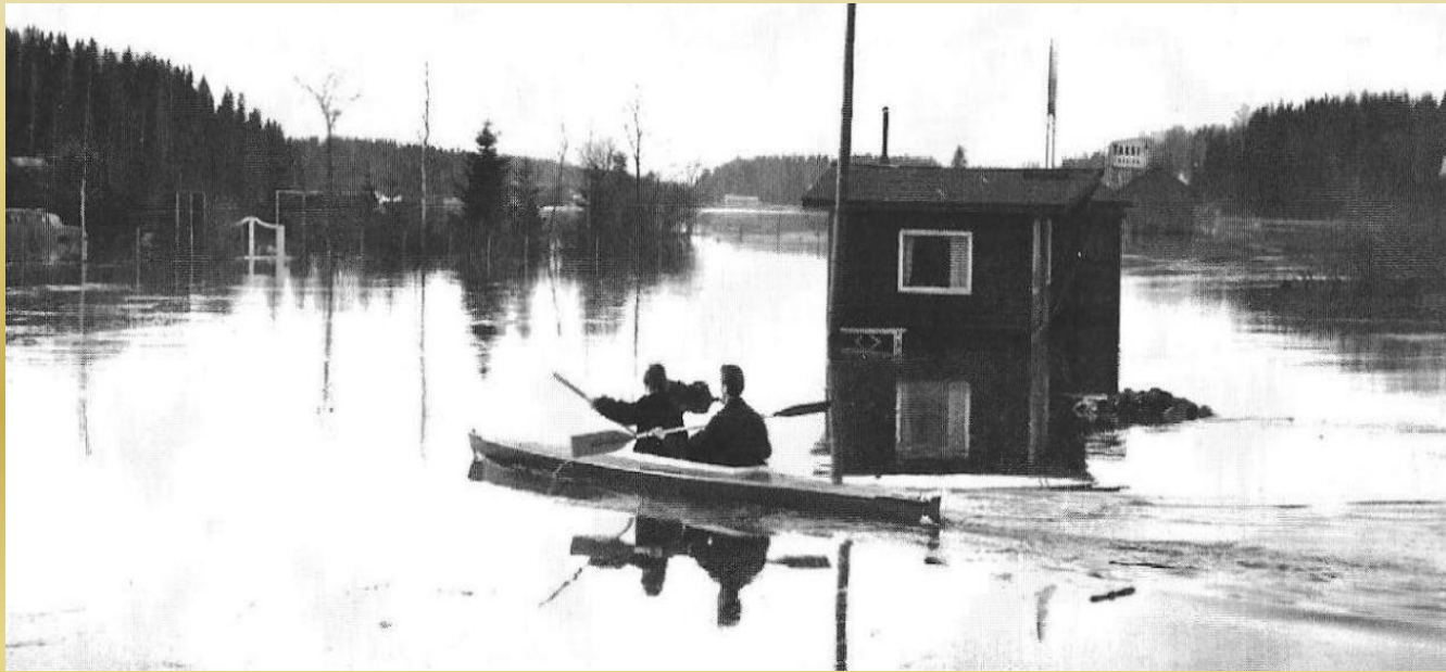
Tulvan valtaama taksikoppi Jokivarren Esson lähellä
